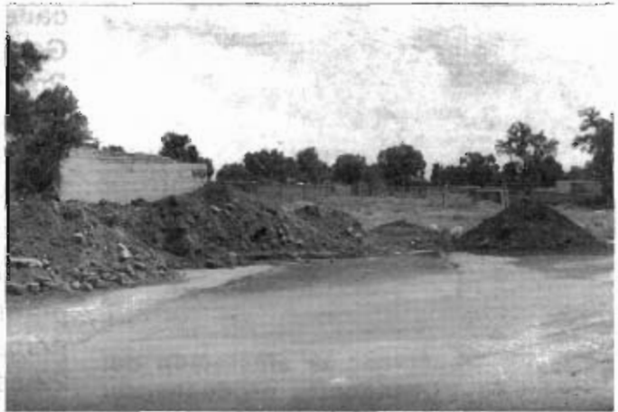
Foto 18. En la imagen se aprecia el relleno y reparación de la cinta asfáltica sobre la calle Isidro González. La foto fue tomada viendo hacia el noreste, en dirección de la Cerrada de Isidro González
