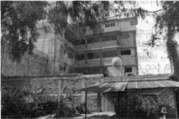
Foto 17. Edificio de 5 plantas que se levantó dentro del área de influencia de la fractura identificada. Dicha construcción se ubica a unos cuantos metros al sur del C.B.T. "Dr. Carlos Graef Fernández"
