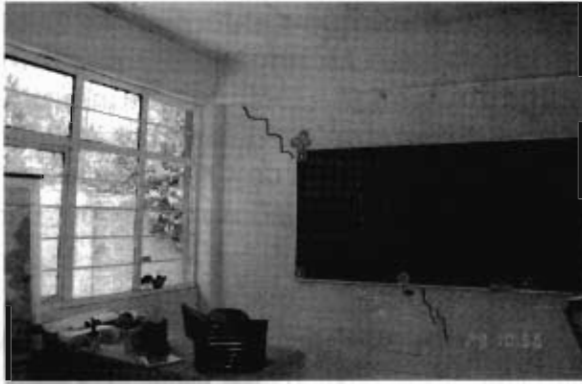
Foto 22. La imagen muestra el agrietamiento en los muros de un aula del plantel
