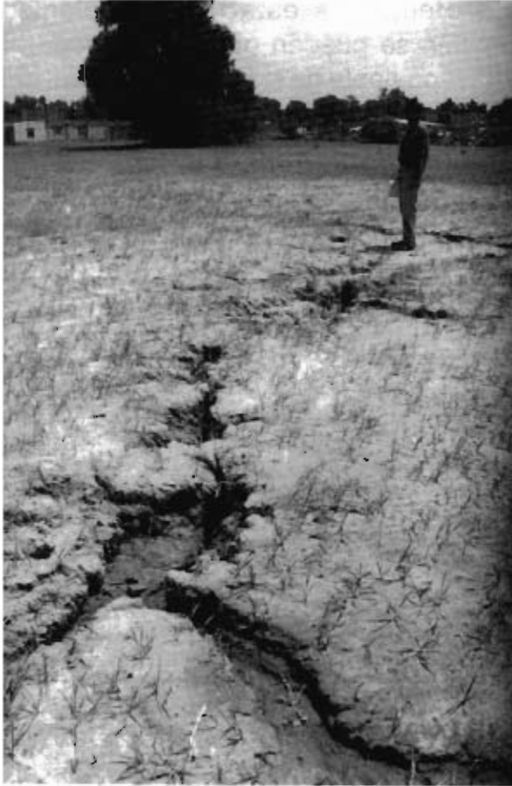
Foto 20. En la imagen, se ve claramente la traza de la "nueva fractura", la cual afecta terrenos de cultivo que colindan con el bordo oriente del Gran Canal del Desagüe. La foto fue tomada viendo hacia noreste, en dirección de la zona urbana
