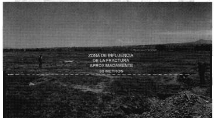
La foto 28, muestra un panorama general de la zona de influencia de la fractura sobre los terrenos del ejido de San Pedro Atzompa. Dicha zona de influencia se estimó en el terreno en aproximadamente 30 metros de ancho. La imagen fue tomada viendo hacia el oriente
